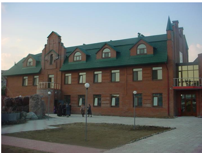
Приходской дом, в котором на 1 этаже расположен приют «Тау»
